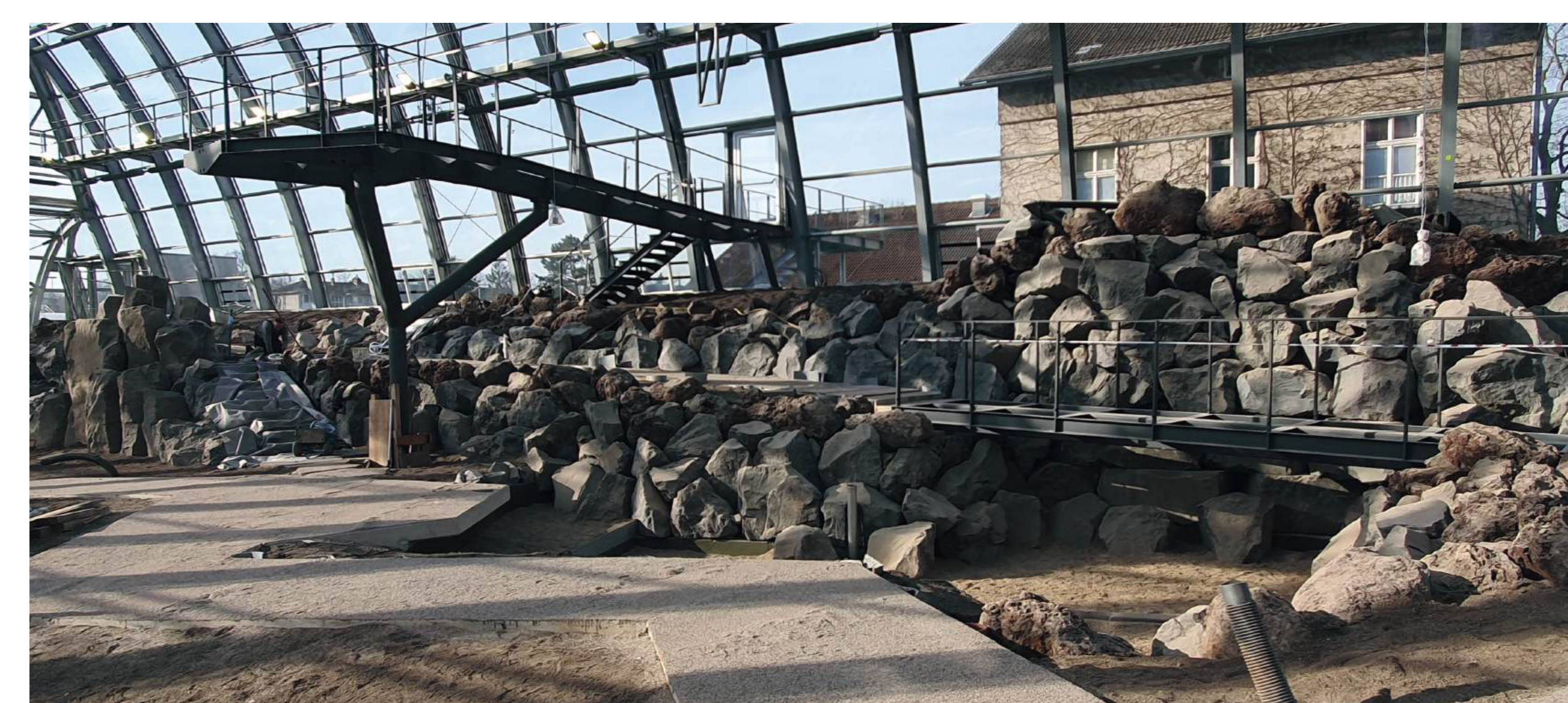
Bau der Natursteinwand aus Lava und Basalt, 2023
